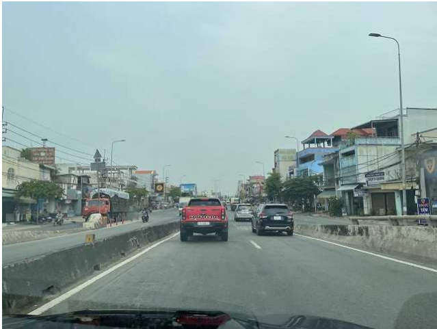
国道 22 号線 路面状態は良好。
