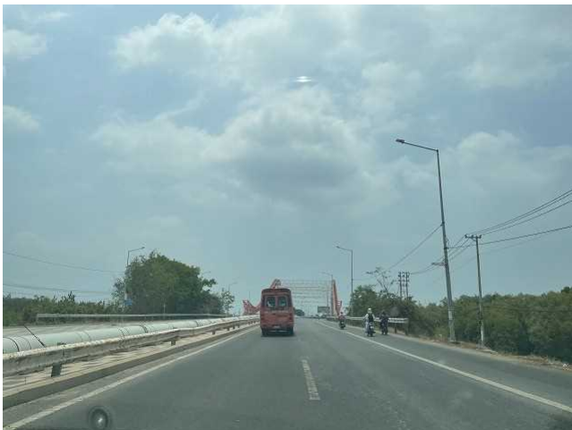
国道 51 号線 中央分離帯があり、同所にインフラ用と思われるパイプが設置されている。
