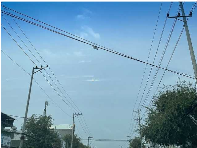
国道 51 号線 架空配線高さ 5.5m。
