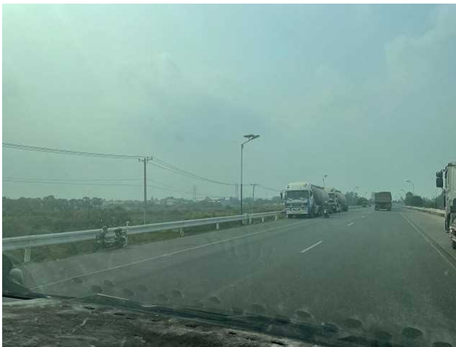
国道 1 号線 路面状態は良好。
