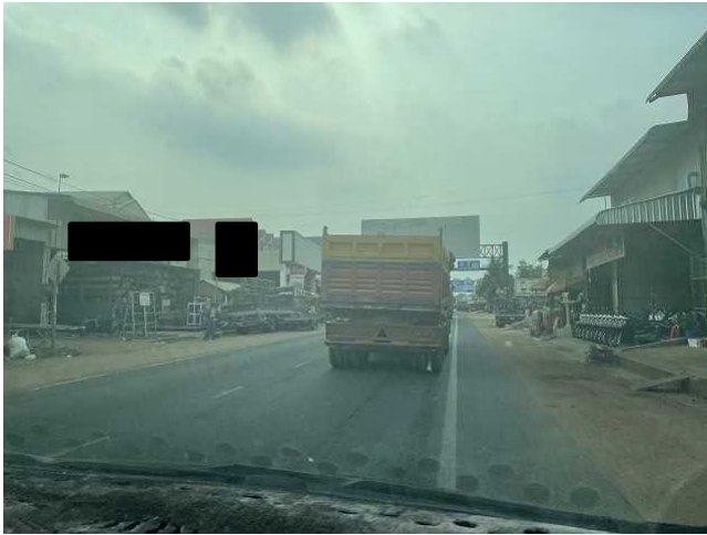
国道 1 号線 路面状態は良好。
