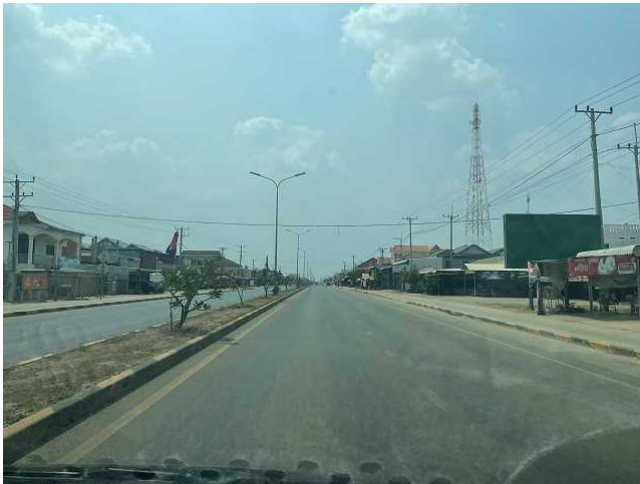
国道 5 号線 路面状態は良好。
