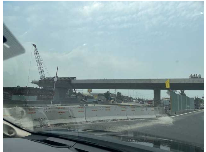
同左 高速道路を建設中
