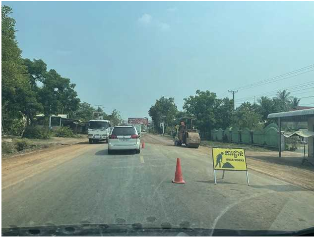
国道 5 号線 整備区間。
