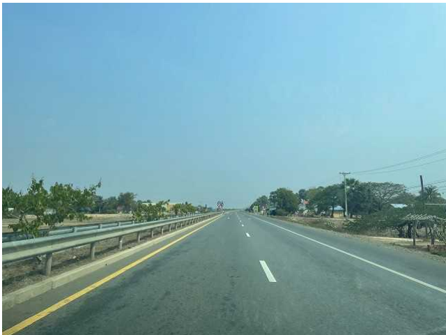
国道 5 号線 路面状態は良好。
