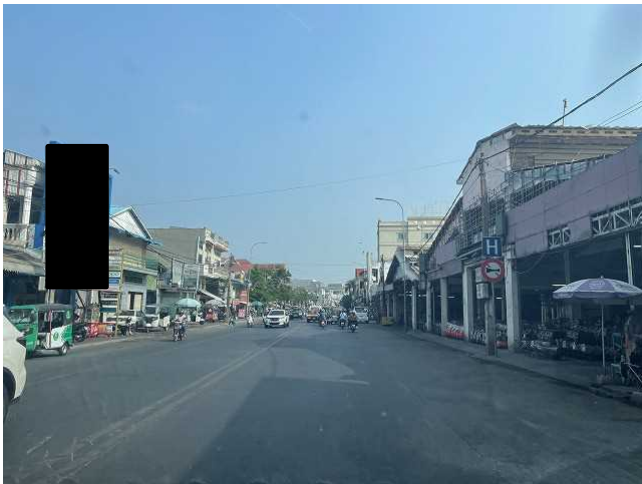
国道 5 号線 路面状態は良好。
