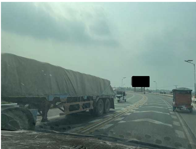
ネアンルック橋 片側 1 車線で路面状態は良好。
