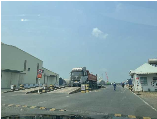
真新しいトラックスケールを2基確認。 速度制限は5km/h、路面状態は良好。
