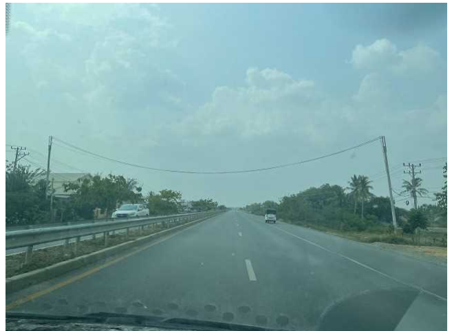
同左 架空配線が下がっている。
