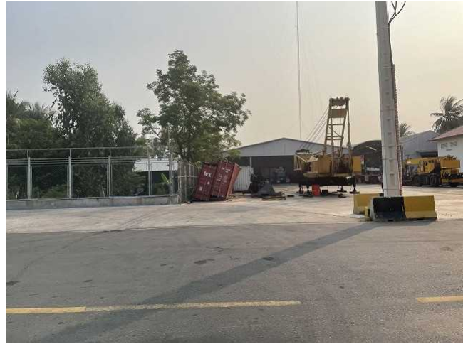
コンテナ修復エリア
