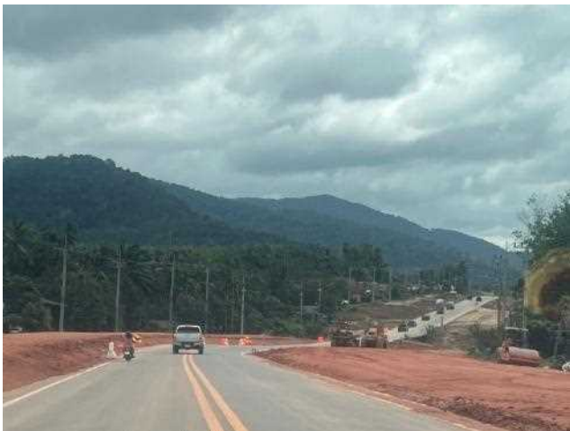
ラノン県 国道 4 号線 (南下中) 片側 1 車線から 2 車線への道路拡張工事が行われ ていた。
