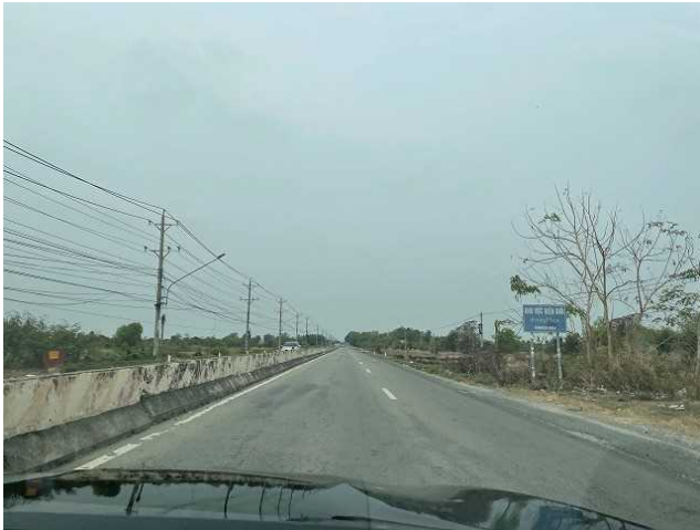
国道 22 号線 路面状態は良好。
