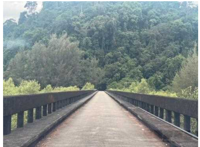
Bang Ben Pier (ボート棧橋)付近の橋
