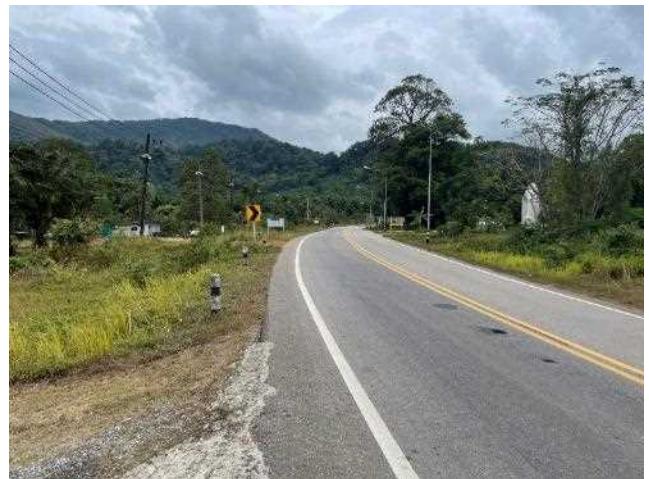
国道入口より約 68km 付近 (チュムポン方面を 撮影)トンネルが正面の山に設けられる予定。
