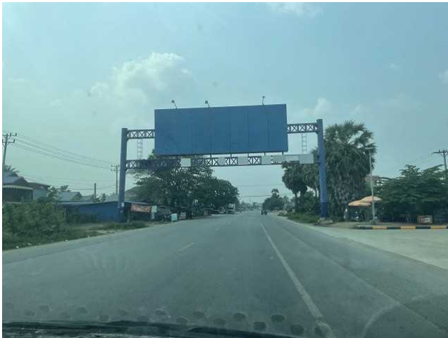
国道 5 号線 標識が消えている。
