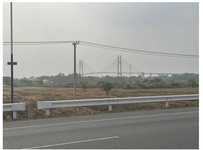
同左 ネアンルック橋
