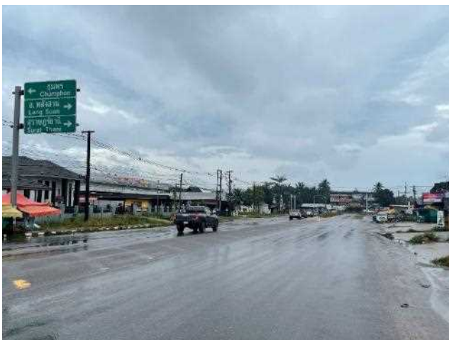
国道 4006 号線入口付近 (チュムポン県方面を撮影)
