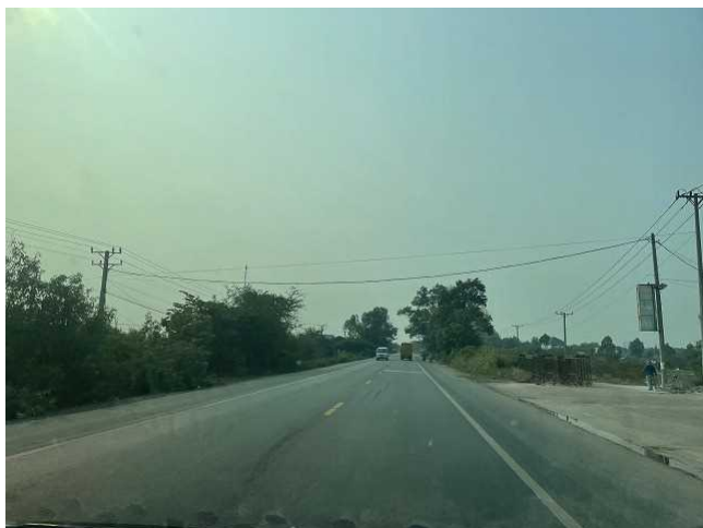
国道1号線 架空配線が下がっていた。
