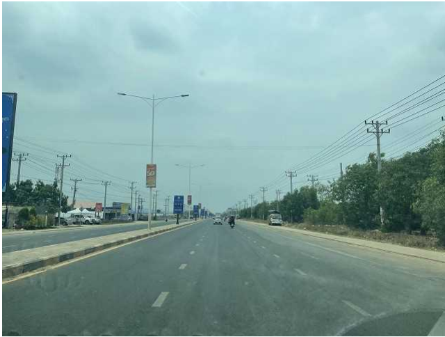
国道 1 号線 路面状態は良好。
