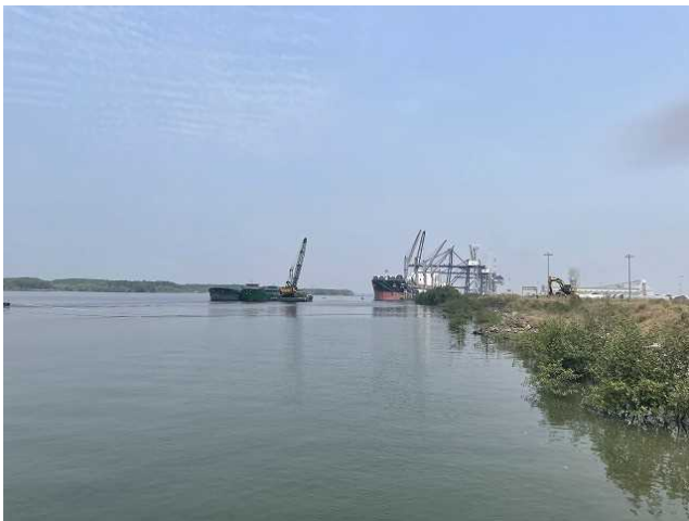
北側の別ターミナル沖で浚渫作業が行われていた。
