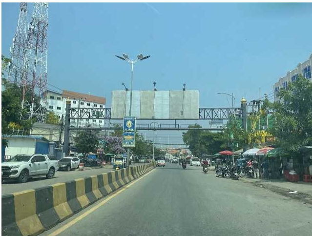
国道 5 号線 路面状態は良好。
