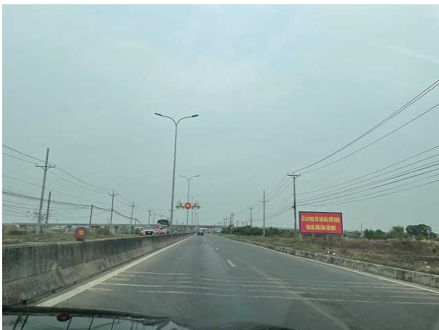
国道 22 号線 路面状態は良好。
