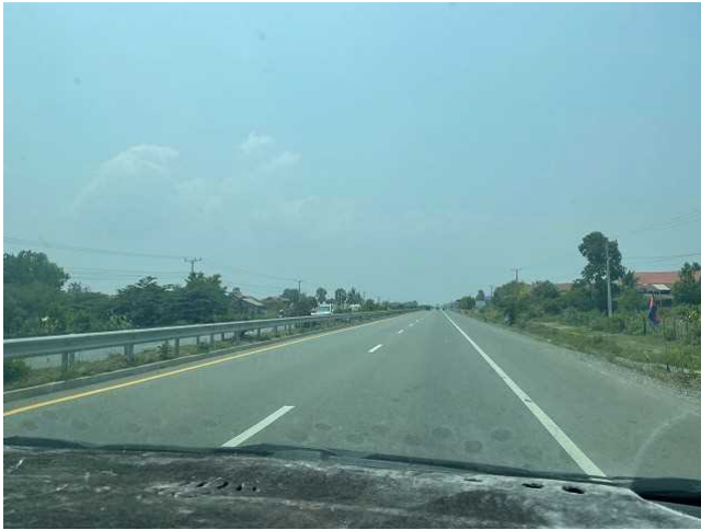
国道 5 号線 路面状態は良好。
