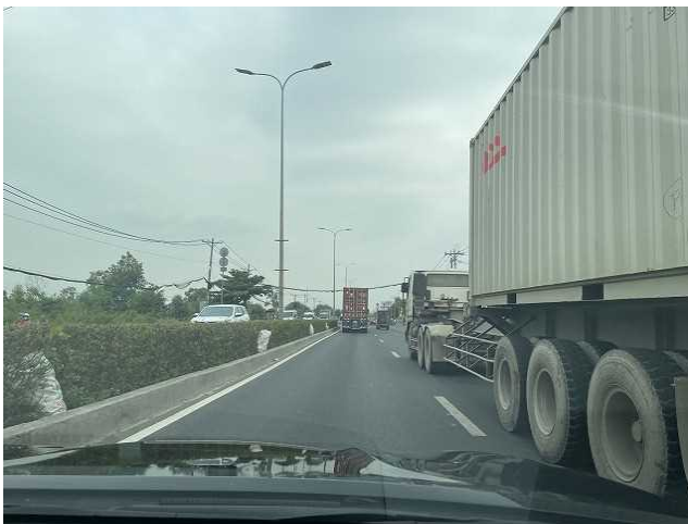
国道 22 号線 路面状態は良好、投機物はない。
