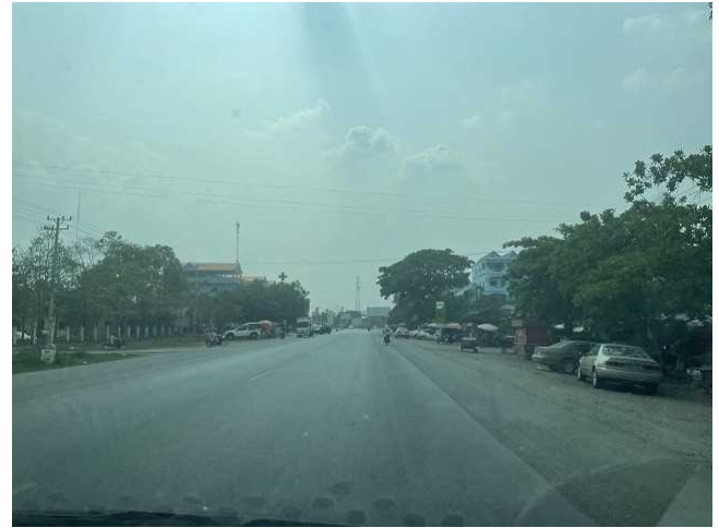
国道 5 号線 片側 1 車線であるが路肩が実質モーターバイクの 走行路になっている。
