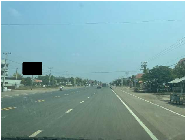
国道 5 号線 架空配線の高さは問題ない。
