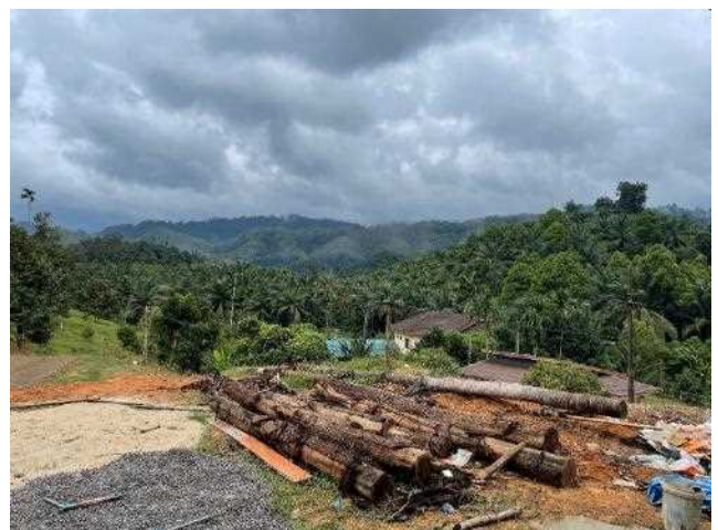
国道入口より約 34km 付近 この付近にランドブリッジ計画の道路が建設予定
