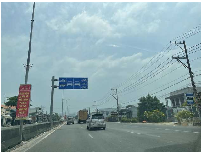
国道 51 号線 片側 4 車線、路線ごとに走行車種が定められている。
