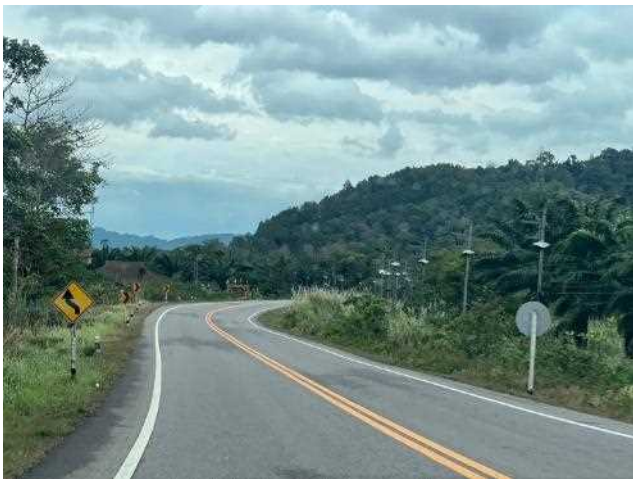
国道入口より約 66km 付近 カーブと下り坂が続いた。
