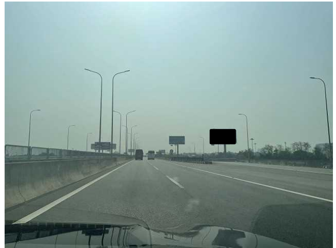
バイパスを走行。路面状態は良好。 片側 2 車線
