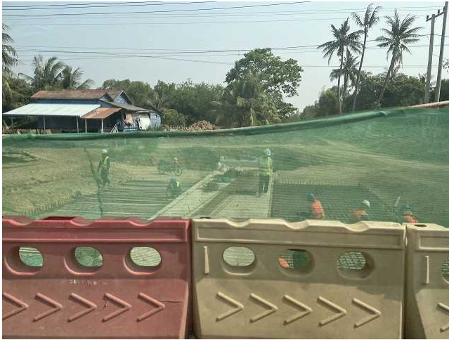
国道 5 号線 橋梁も改修
