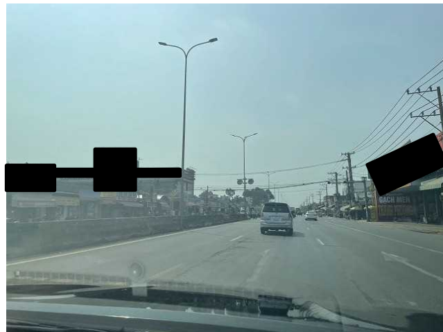
道路標示は若干摩耗しているが視認性は残っていた。
