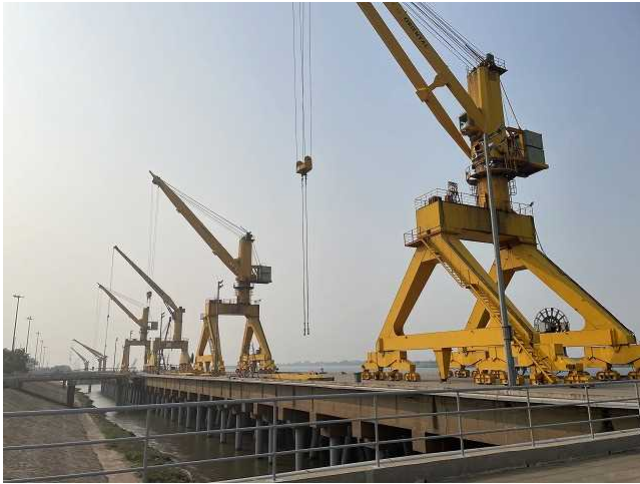
陸上クレーン
