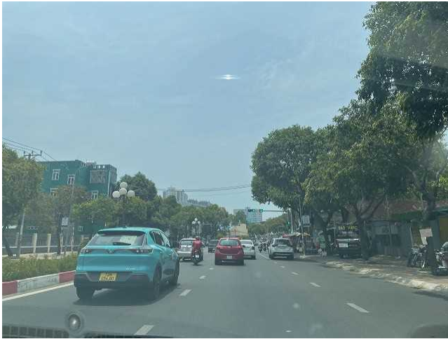
国道 51 号線 路面状態は良好。
