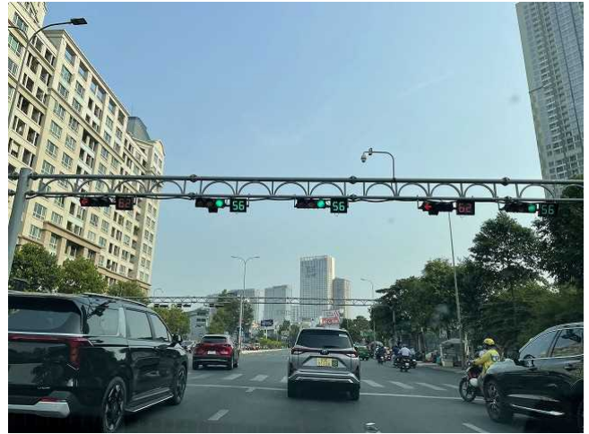
市街地では各車線に信号機が設置されていた。秩序だって走行されている印象を受けた。
