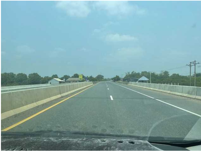
国道 5 号線 路面状態は良好。
