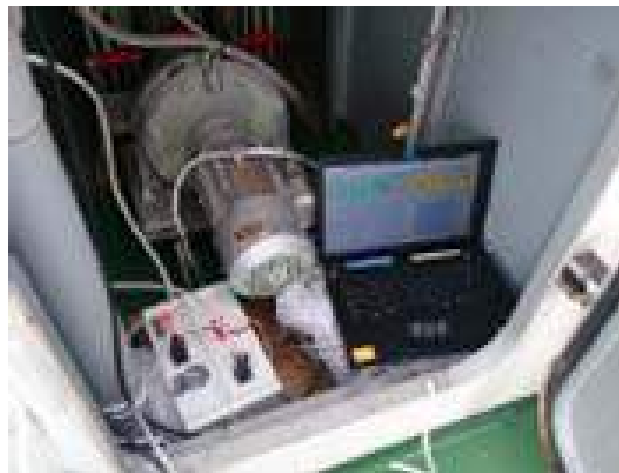
図 2-4 : 遠隔監視装置
