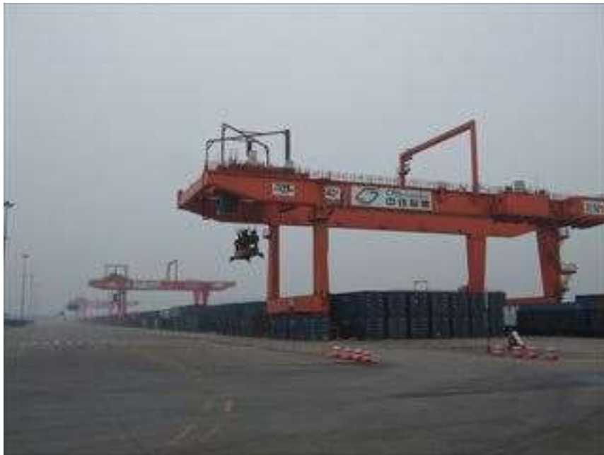
図表 33 重慶西部物流園区コンテナヤード
