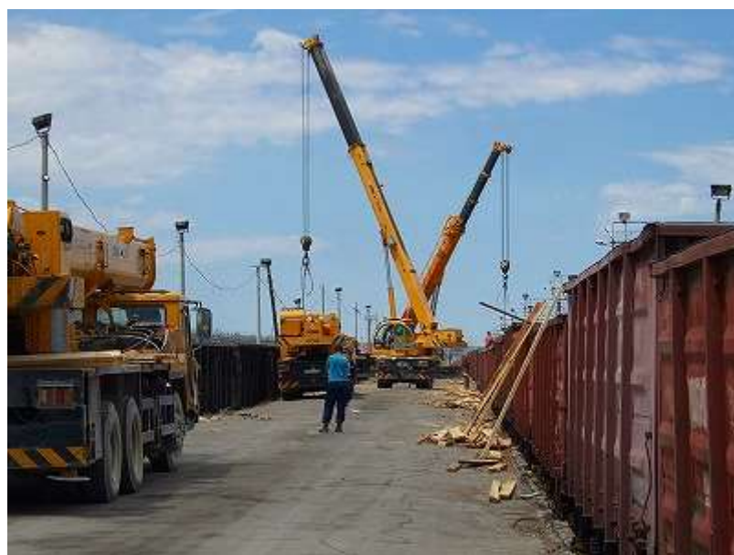
図表 57 貨物積替えエリア3 ～移動式クレーン車両による作業風景～
