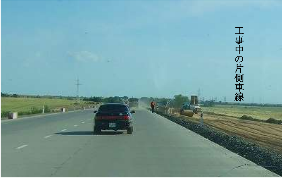
図表 40 片側車線を改修中の道路
