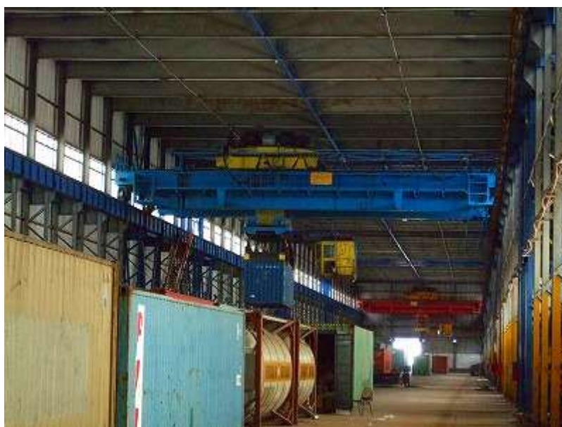
図表 53 貨物積替えエリア 2 ～35t 天井クレーンによるコンテナ積替えの様子～
