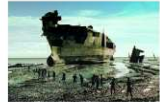
労働安全・環境対策がされていない途上国の解体施設
