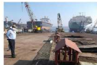
適正に管理された解体施設
