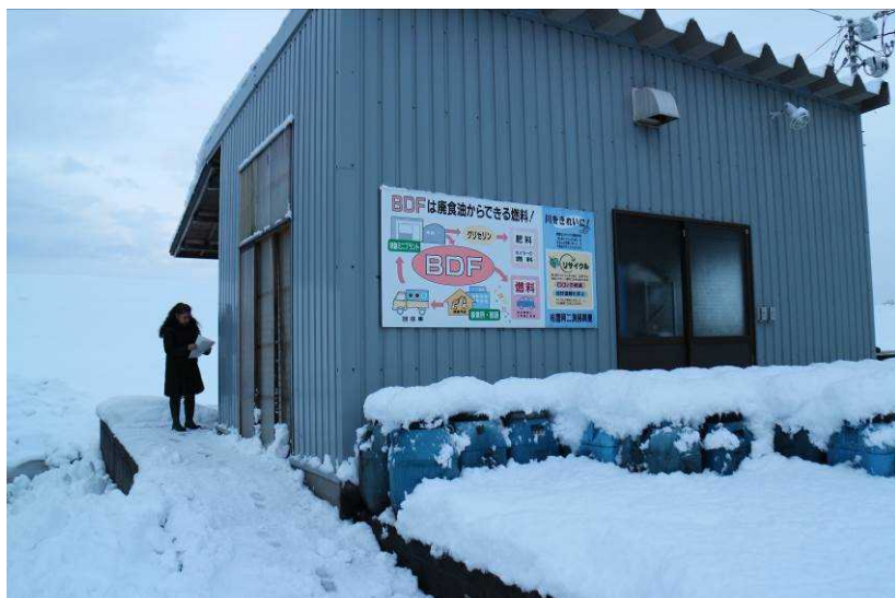
Fig. 3-4 BDF 製造施設建物外観 (於 鷹阿二清掃興業, 2014 年 12 月 9 日撮影)
