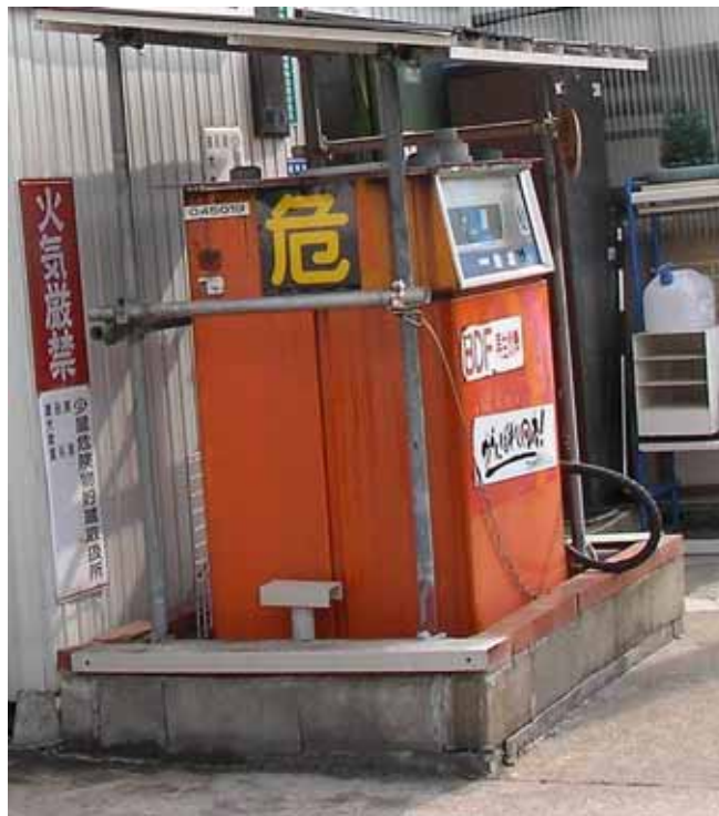
Fig. 3-3 BDF 給油設備 (於 事業所 C, 2012 年 8 月 29 日撮影)
