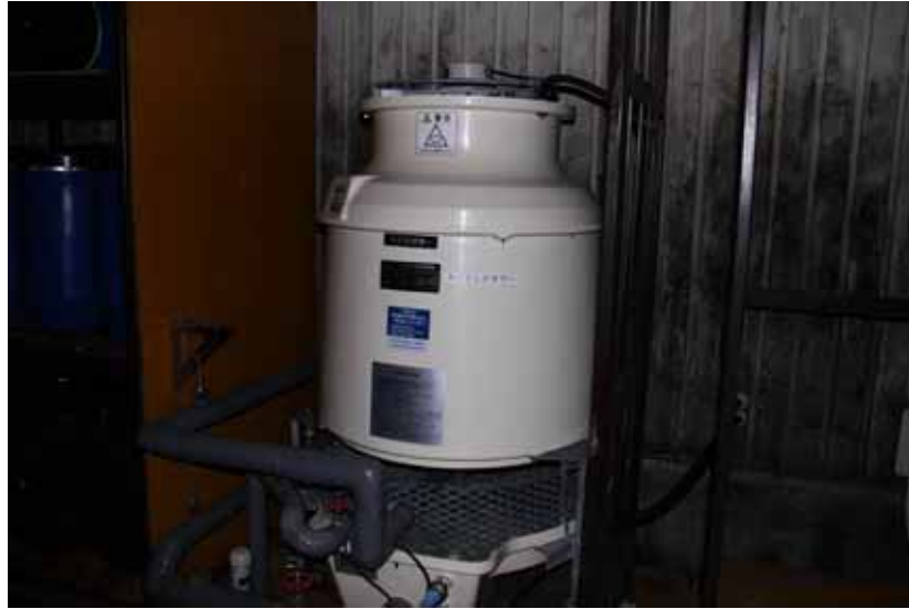
Fig. 3-8 BDF 製造装置付属のクーリングタワー (於 事業所 B, 2012 年 12 月 6 日撮影)
