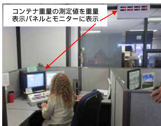
写真 3.1-9 ゲート監視室 輸出コンテナ情報、搬入トラック情報の確認 (コンテナ重量表示パネルにて測定重量を表示)
