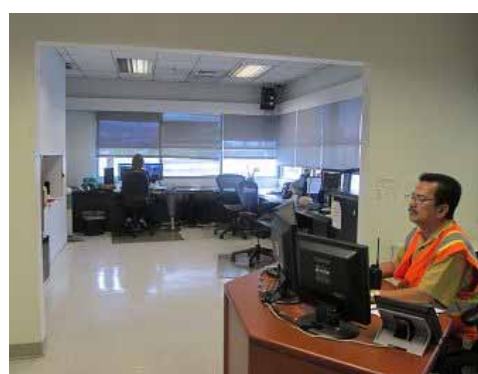
写真 3.1-12 ゲート監視室全景 (奥がゲート監視室: モニターとマイクにより搬入シャーシとコンテナ情報を確認)
