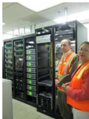
写真 3.1-8 コンテナ重量演算制御室 (ロードセルデータよりコンテナ重量を演算)
