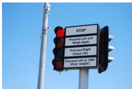
写真 3.2-6 結果表示パネル
