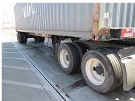
写真 3.1-7 コンテナ重量測定ピット (ピット内にロードセルが設置)
