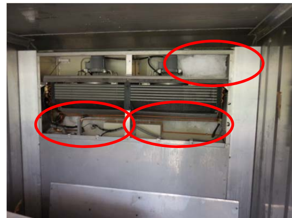
【図 24】 奥パネルを開放した状態 (氷の塊が散見)
