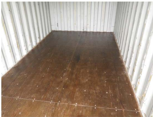
【図6】ニス塗りの床板の状態
