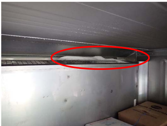
【図 23】 コンテナ奥天井部付近の様子 (氷の塊が見えている。)
