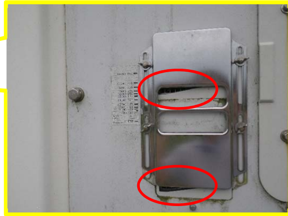
【図 20】 ベンチレーションの開放状態(10%開放)
