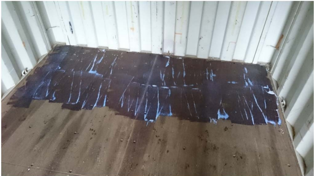
【図5】床板ニス塗り作業状態
