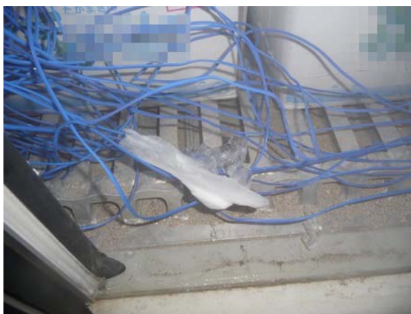
【図 25】 ドアとドアのつなぎ目に氷発生
