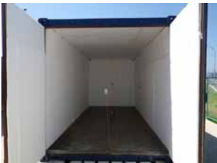
図12: コンテナDの内貼り
