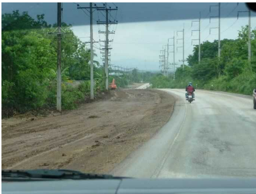
【1020号線（拡張工事区間）】
