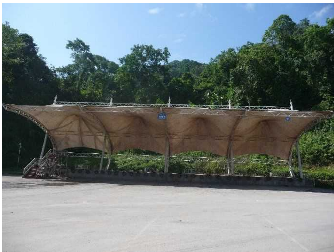
【貨物検査スペース】
