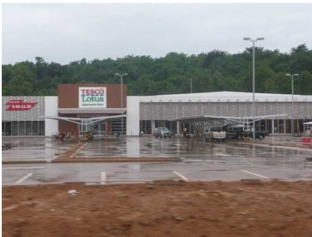
【チェンコーン市郊外に建設中のハイパーマート（TESCO Lotus）】
