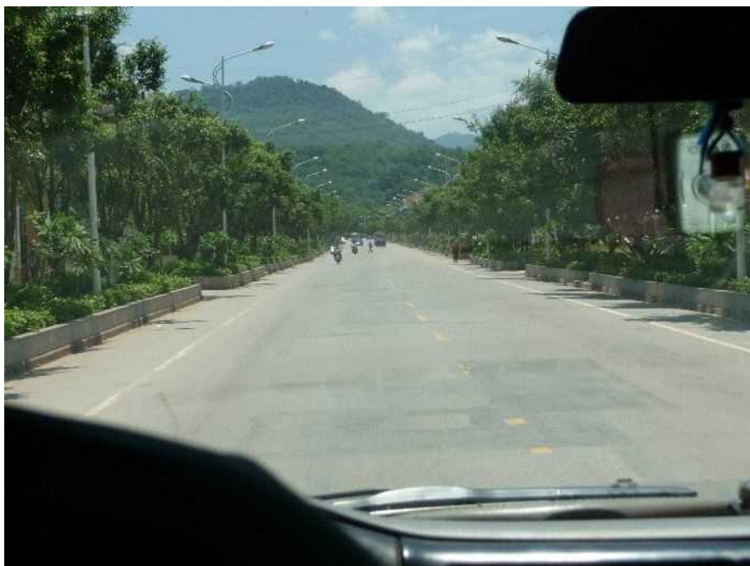
【真っ直ぐに走る 2 車線区間（メンラー付近では街灯が設置されている）】
