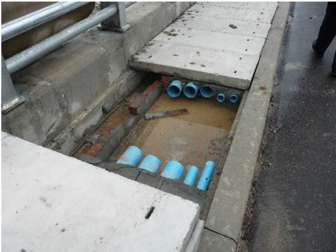
【配管工事の様子】
