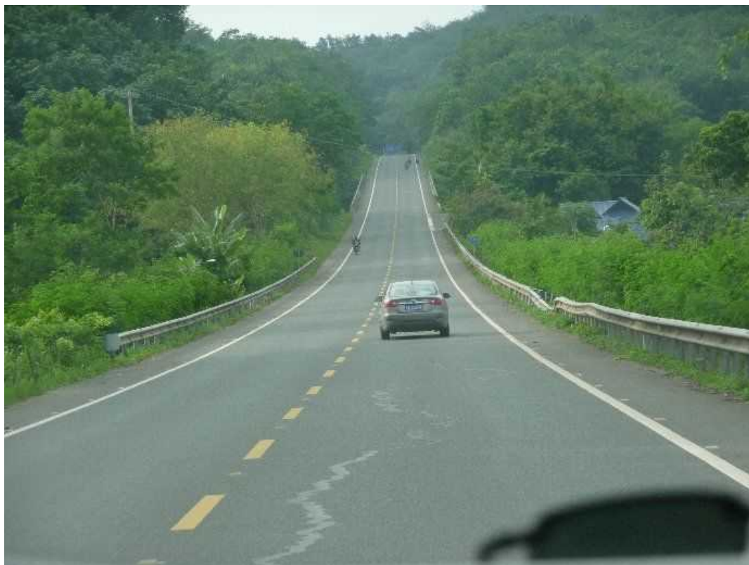
【真っ直ぐに走る 2 車線区間（モーハン～メンラー間）】
