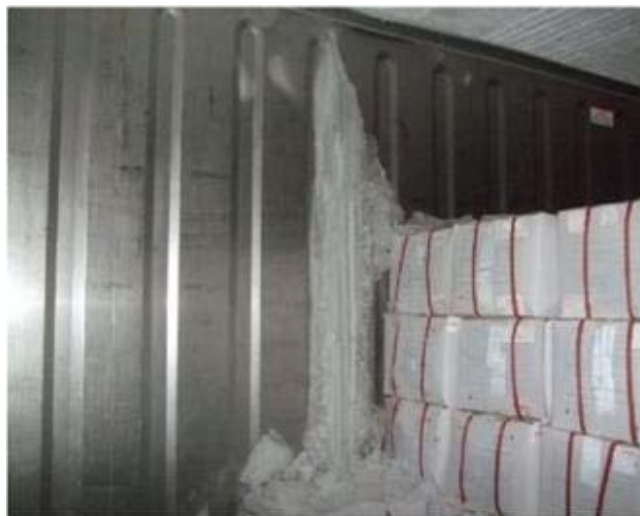
写真4：コンテナ内に流入した雨水
