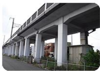
高架橋柱耐震補強
