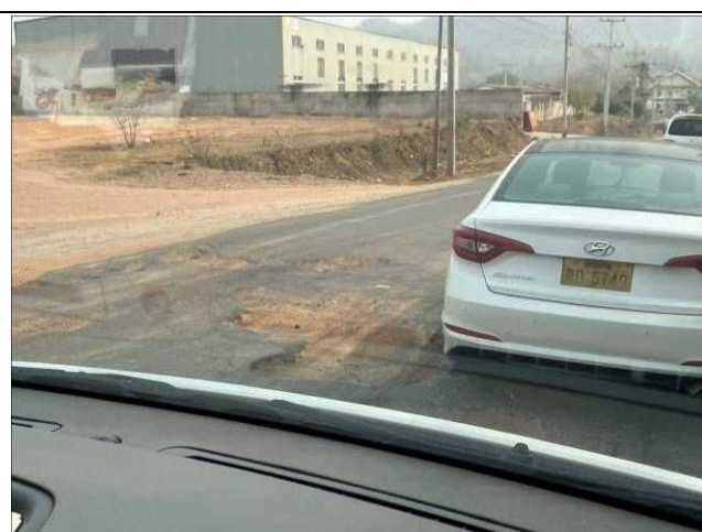
舗装されているように見えるが路面の状態は良くない
