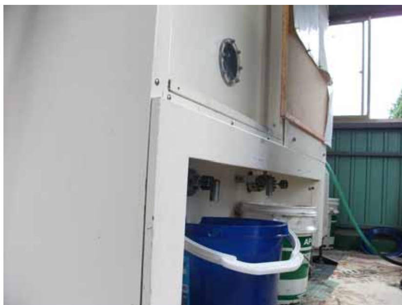
Fig. 3-4 BDFの取り出し口 (於 鷹阿二清掃興業, 2013年7月31日撮影)
