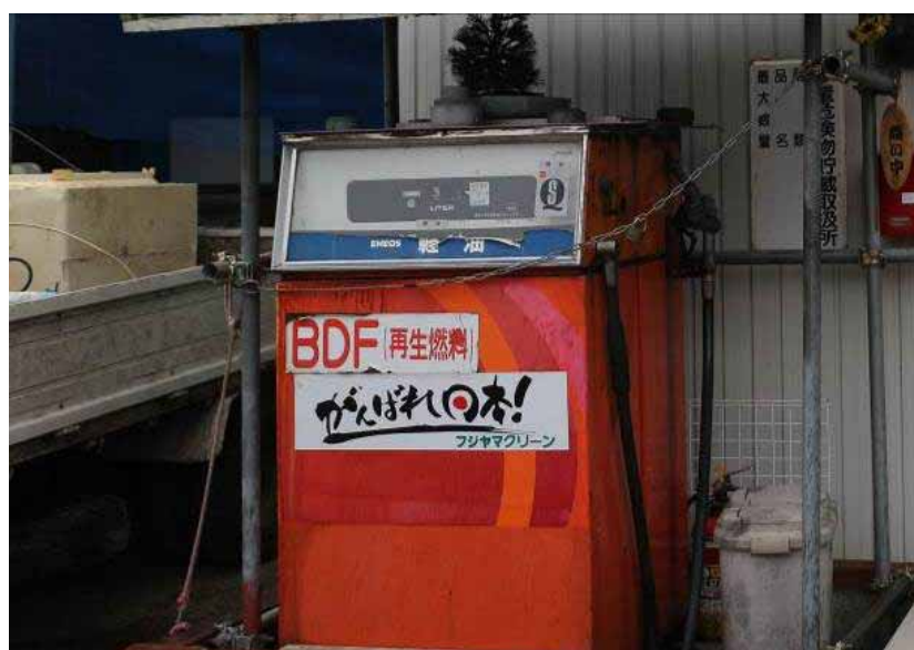
Fig. 3-19 BDF 給油装置 (於 フジヤマクリーン, 2013年12月10日撮影)
